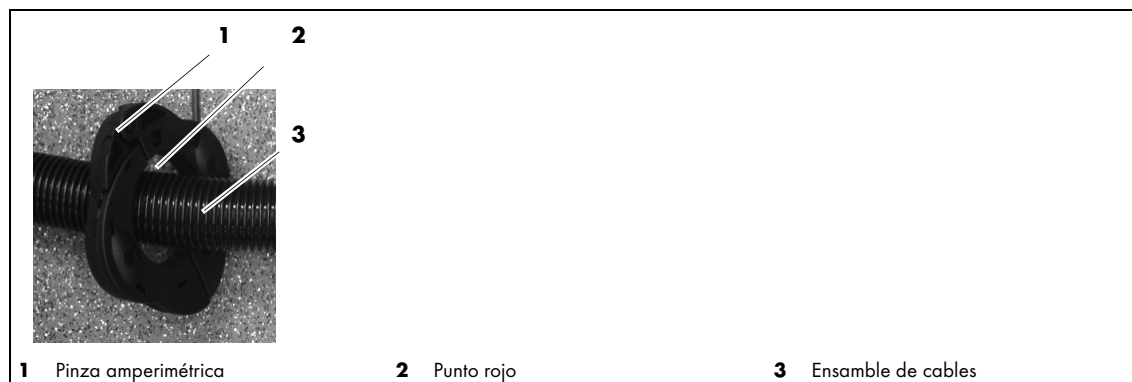
Fig. 8 Pinza amperimétrica alrededor del ensamble de cables
